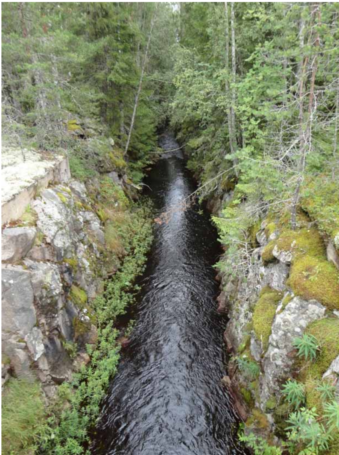
Figur 1:3. Masksjöbäcken cirka 500 meter nedströms Skredsvikssjön. Kraftig nedsprängning av vattendraget i samband med torrlägningsföretaget. Foto: Johan Andreasson.
