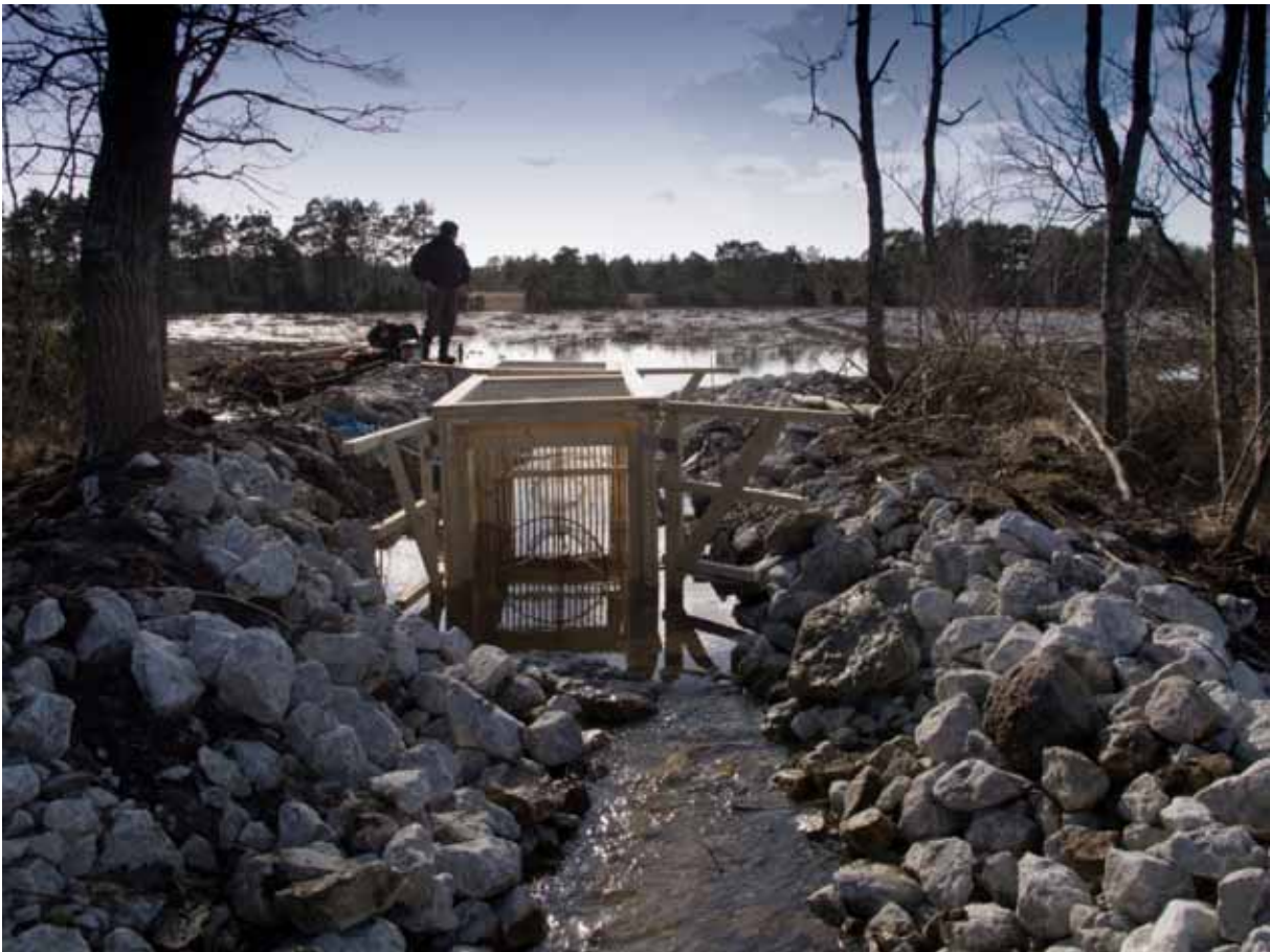
Figur 14. Fiskvägen vid Österby myr. Under våren 2012 fångades de stigande gäddorna i en fälla som utvärdering av projektet. Efter dokumentering släpptes i myren som du ser i bakgrunden. Foto: Micael Söderman
