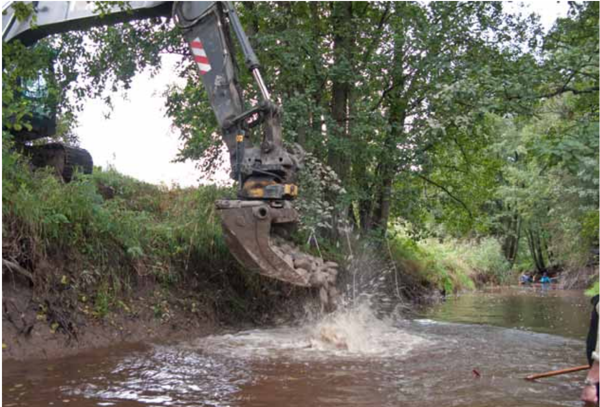
Genom att återföra sten och grus till åfåran har Länsstyrelsen inom kilaåprojektet försökt att återställa de biologiska värdena i delar av den hårt ränsade åfåran. Foto: Nils Ljunggren
