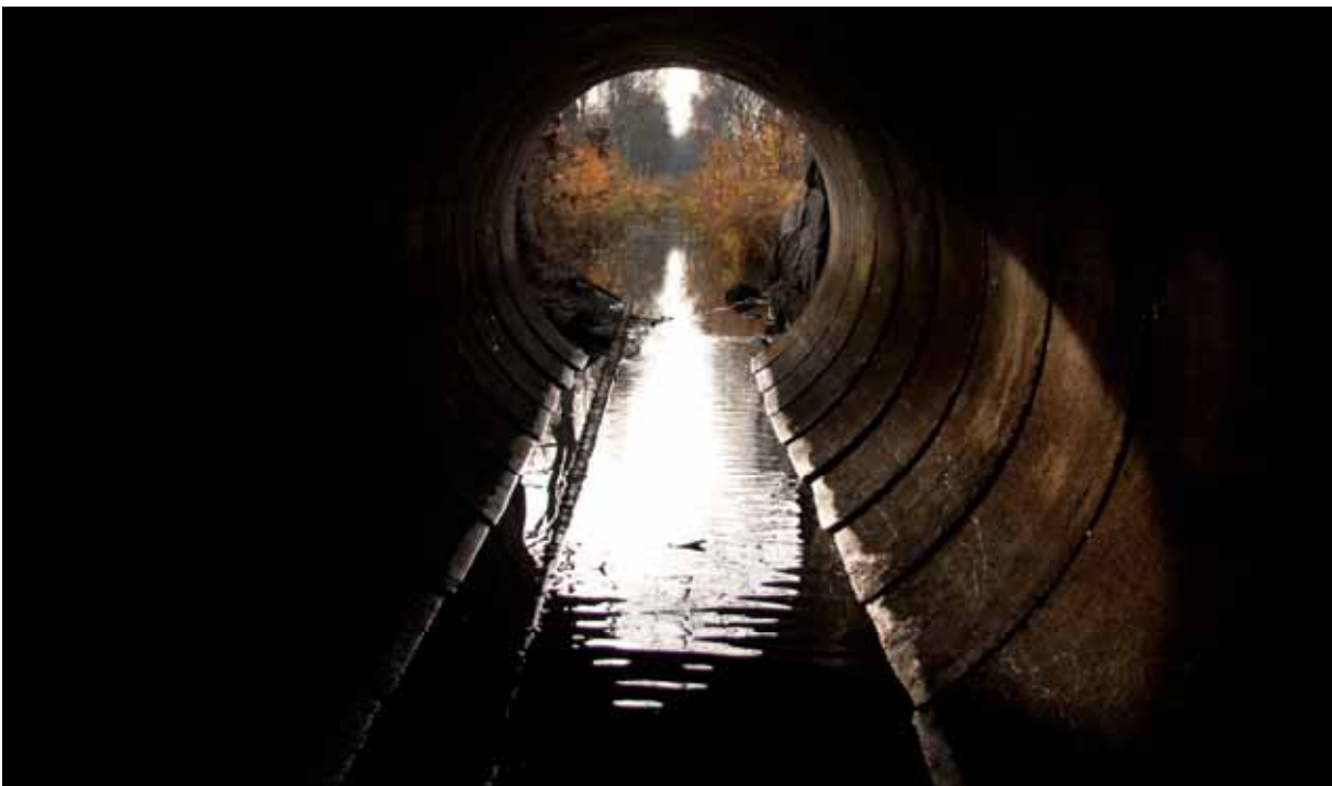
Figur 6:5. En stor del av Limmarån är idag kulverterad och fisk hindras från att stiga för lek. Foto: Micael Söderman
