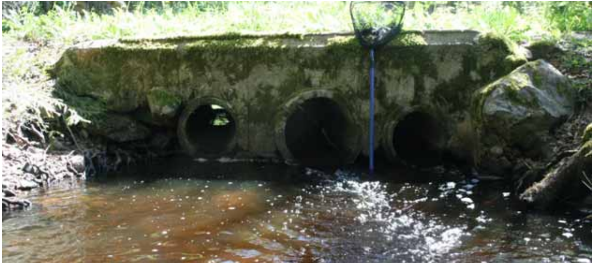
Figur 3:3. Strax innan mynningen i Tårterviken finns en mindre vägbro vars trummor vid låga flöden kan utgöra ett vandringshinder. Foto: Per Stolpe
