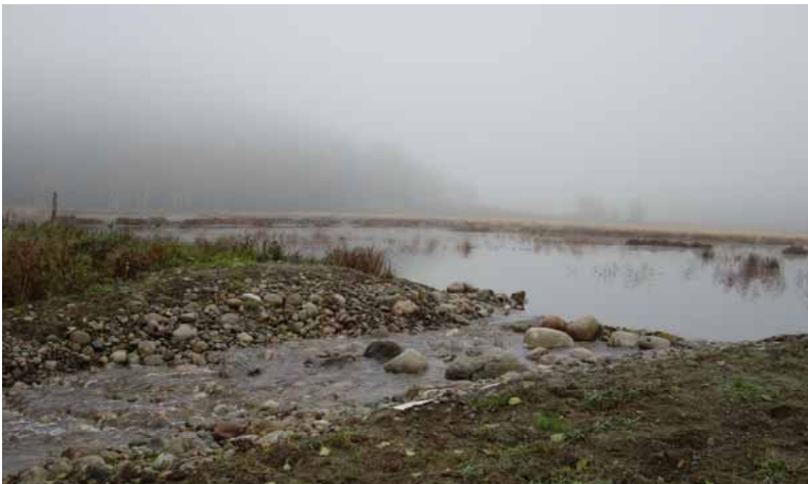
Figur 8:6. Omlöp anlagt i dammvallen vid Sportfiskarnas våtmark i Snäckstavik nedströms Kyrksjön. Omlöpet tillåter fri passage för alla vattenlevande organismer under den period då våtmarken är fylld och lekvandrande gädda på över sju kilo har konstaterats simma upp i våtmarken. Foto: Nils Ljunggren
