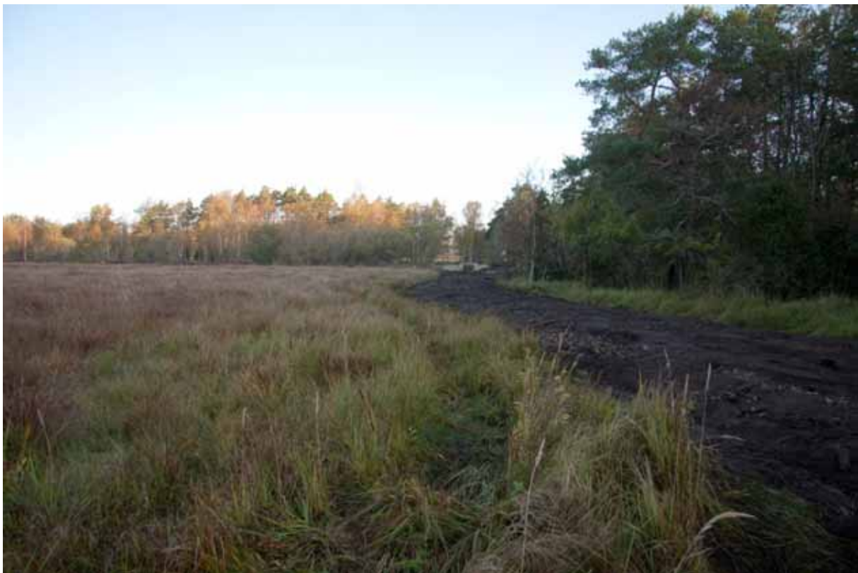
Figur 11. En diskret vall anlades utefter två av Österby myrs sidor. Detta gjorde att vattnet kvarhölls i myren tills den tömdes i slutet av maj. Tidigare har den ofta torkat ut redan i början av april. Foto: Micael Söderman
