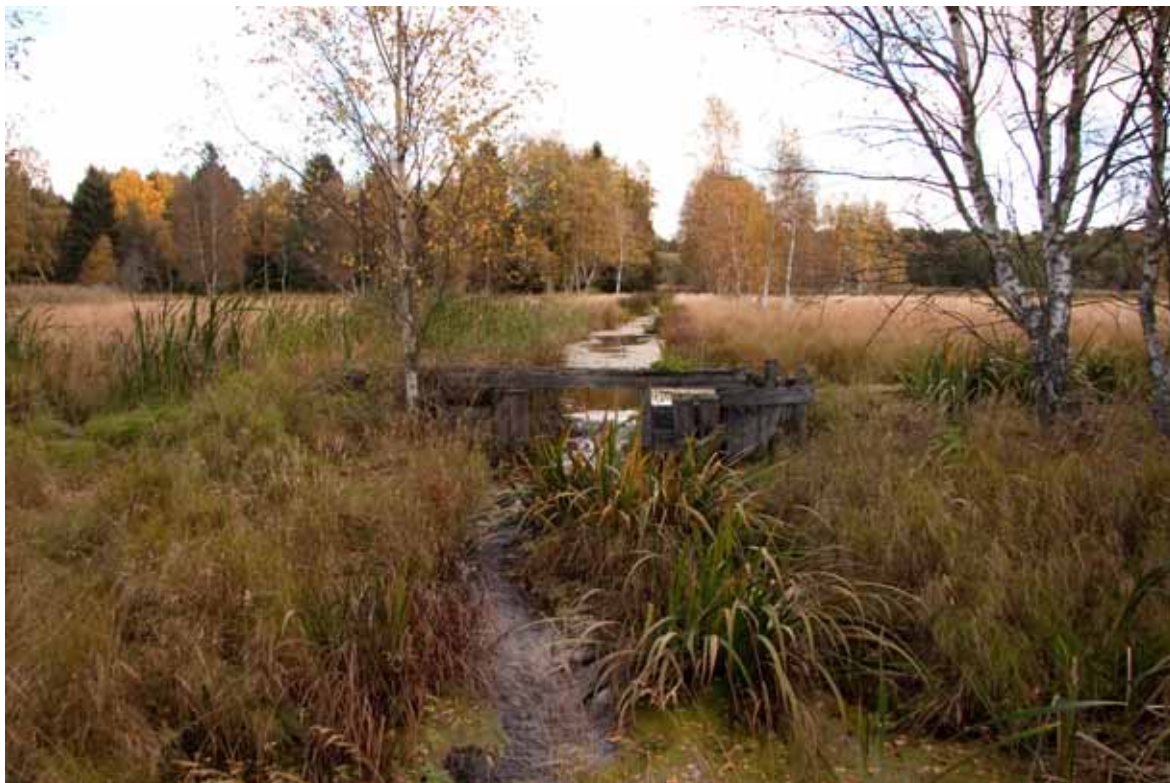
Figur 8:4. Nuvarande damm för reglering av Kyrksjöns vattennivå uppfördes på 1970- talet och är idag i mycket dåligt skick. Bäver dämmer regelbundet utloppet och höjer då tillfälligt vattennivån uppströms. Foto: Micael Söderman
