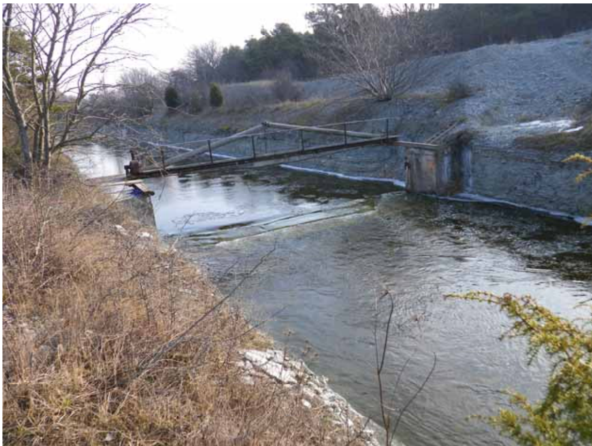
Figur 19:6. Snoderån är reglerad med ett antal dammluckor i huvudvattendraget, den så kallade storkanalen. Luckan på bilden, här i nedfällt läge, är placerad cirka två kilometer uppströms projektområdet för planerad våtmark. Foto: Lars Vallin
