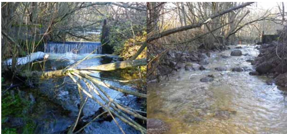
Figur 19. Till vänster damm som utgör vandringshinder för svagsimmande fiskarter (id, abborre, gädda med flera). Till höger samma plats efter fiskevårdsåtgärd i form av tröskling med stenmaterial. Foto: Lars Vallin
