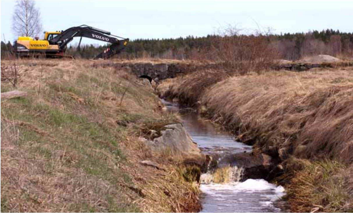
Figur 6:4. I Storträskån stiger stora mängder fisk för lek på våarna. Bergklacken på bilden utgör numer ett vandringshinder efter att ån nedströms har muddrats och vattenytan sänkts. Uppströms stenbron finns en våtmark för fåglar anlagd. Tyvärr hindras fisk från att vandra in i den. Foto: Micael Söderman
