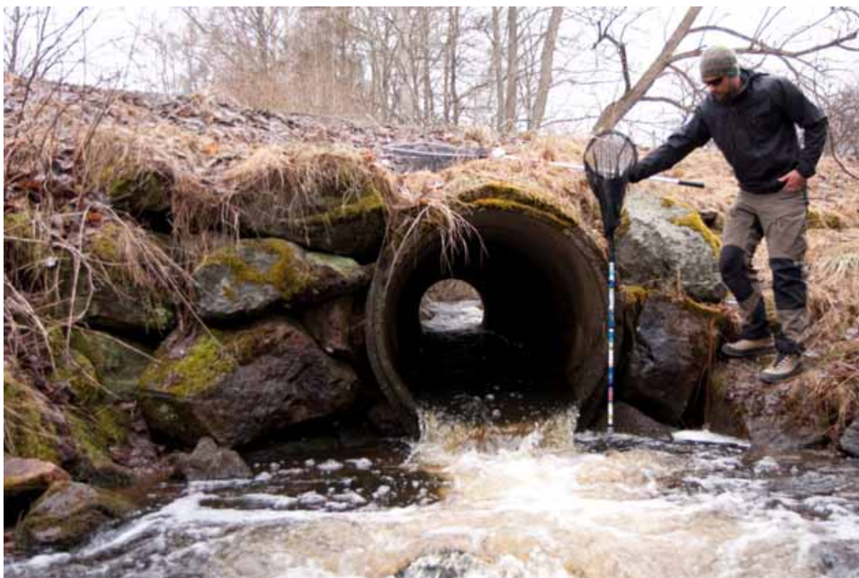
Figur 17. Den fellagda vägtrumman är ett delprojekt som är helt avgörande att åtgärda för att få upp fisk till våtmarken. Foto: Micael Söderman
