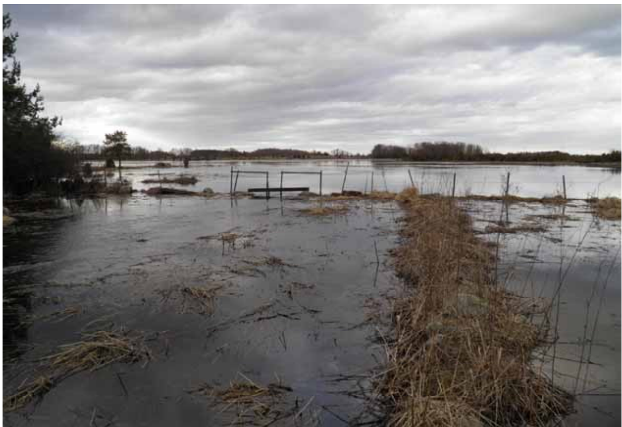
Figur 18:5. Harfjärdens nuvarande bristfälliga fördämning utgörs av en gammal stengärdesgård Foto: Jonas Nilsson
