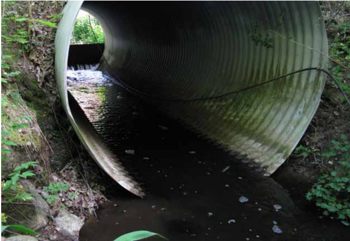
Figur 12:5. Den anordning som idag reglerar långsjöns vattensystem utgör definitivt vandringshinder för vattenlevande organismer. Foto: Nils Ljunggren
